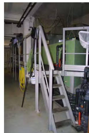
Des galeries techniques permettent d'accéder aux aquariums afin d'en assurer la maintenance
