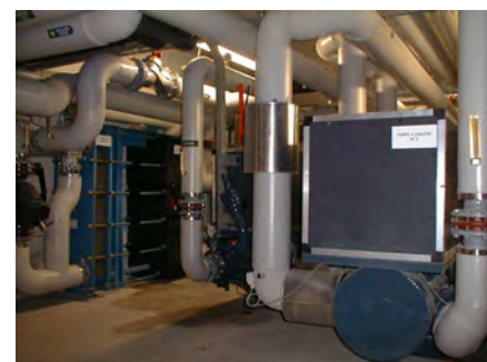
La régulation thermique des aquariums est assurée par des pompes à chaleur
