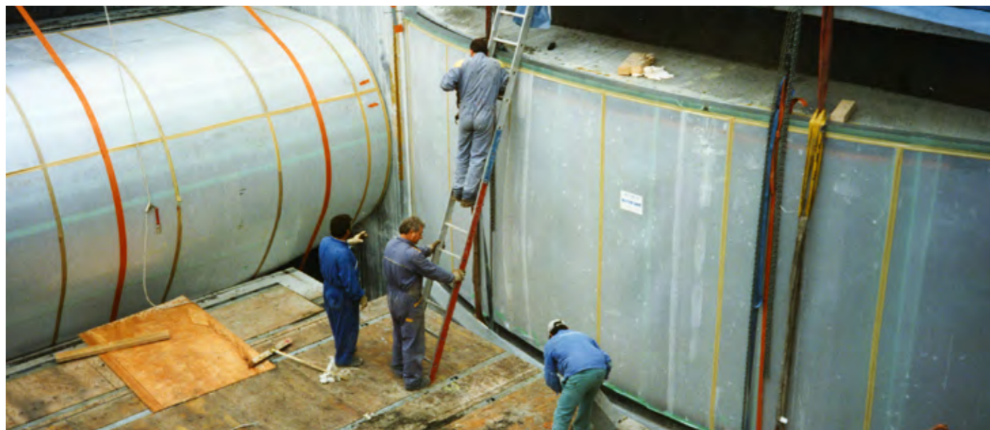
Pose de la paroi en méthacrylate de l'aquarium des requins.
